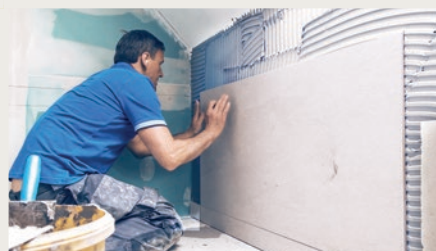
Για επικόλληση πλακιδίων σε τοίχους ξηράς δόμησης γυψοσανίδας ή τσιμεντοσανίδας
