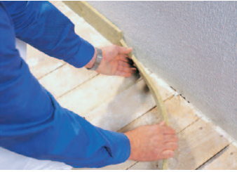
Randdämmstreifen werden an allen Wänden, Stützen etc. aufgestellt
