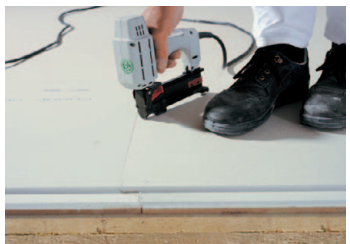
Schrauben oder mit Klammern im Abstand \leq 30 cm fixiert
