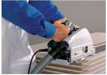
Bei Wandanschluss wird der obenliegende Falz abgeschnitten
