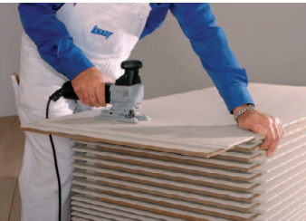
Knauf Brio lässt sich sowohl mit der Kreissäge als auch mit einer Stichsäge schneiden
