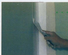
Andrücken des Profils mit der Spachtel...
