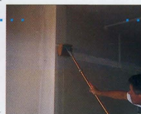
...trägt auf und gleicht Unebenheiten aus
