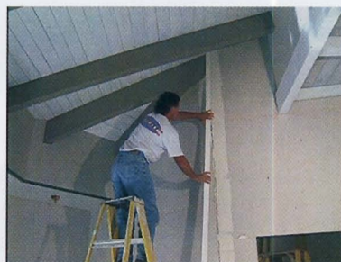
Anlegen des Profils an einer Außenecke
