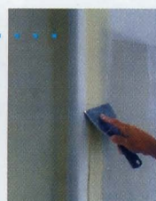
Die Spachtel beim Glätten eines ULTRA BULL-Profils...
