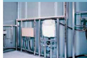
Instalación en el tabique de Knauf
