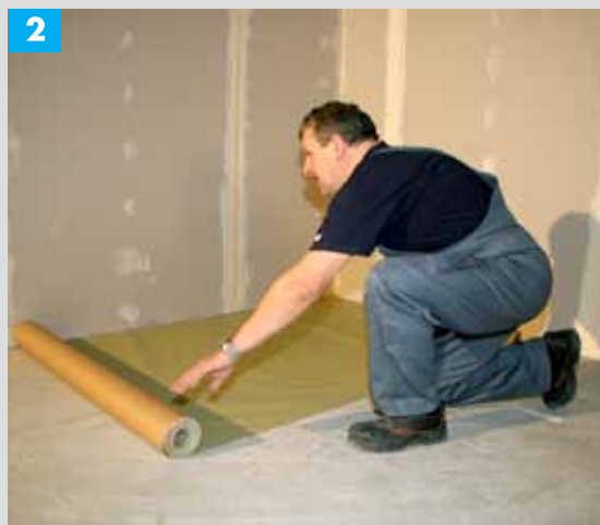
Uz koka siju pārseguma jāuzklāj gaisa caurlaidīgs hidroizolācijas slānis
