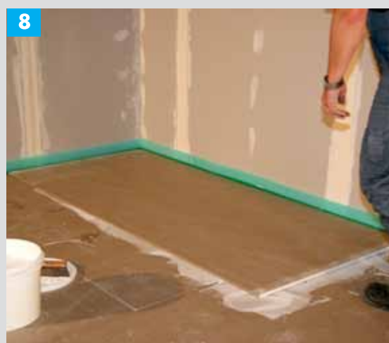
8 Montē otro Knauf BROWN plākšņu kārtu
