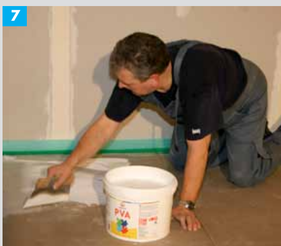
7 Pirms augšējās kārtas uzlikšanas pirmās kārtas plāksnes pārklāj ar PVA līmi, izmantojot roboto ķelli ar 3 mm zobojumu.
