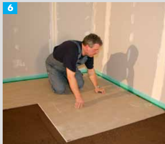
6 Uz sagatavota, pilnīgi izlīdzināta pabēruma vispirms cieši citu pie citas vienā kārtā ieklāj Knauf BROWN ģipškartona plāksnes
