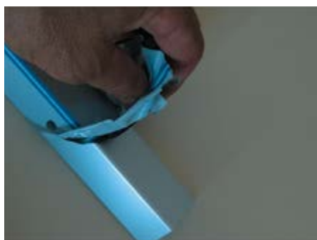
Retire el film protector de los perfiles de aluminio
