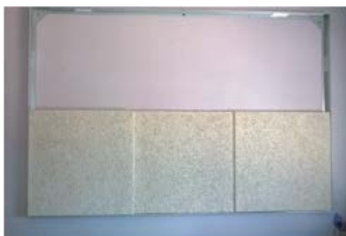
Coloque y sujete el resto de paneles
