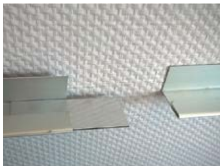
Introduzca las guías con la pieza de retención visible
