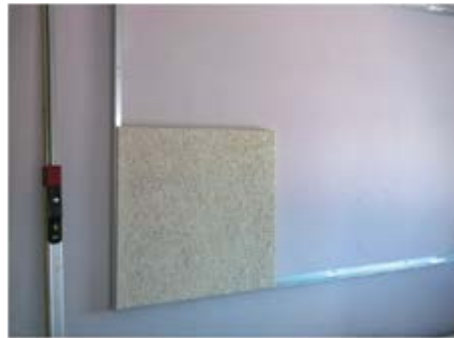
Coloque el panel en el marco presionando contra el soporte
