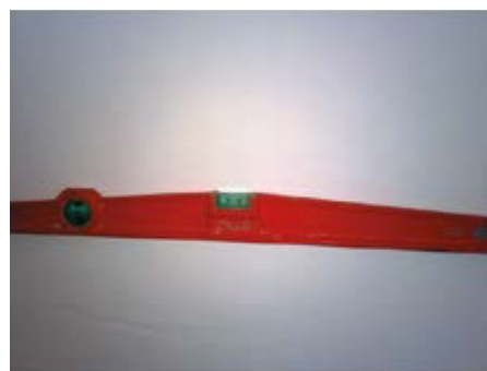
Trace la línea inferior con un nivel
