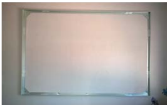
Coloque y sujete el resto de perfiles
