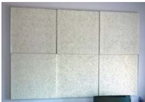
Coloque el panel en el marco presionando contra el soporte
