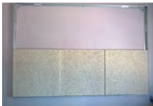
Coloque e sujeite os restantes painéis
