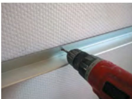
Coloque o perfil de 1200 sobre a linha e fure os 3 buracos
