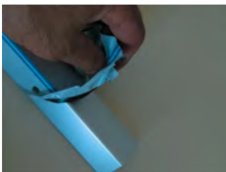
Retire o film protetor dos perfis de alumínio
