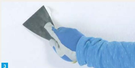
Mit Spachtel die aufgetragene Füllmasse fest in den Untergrund einarbeiten und glatt ziehen. Überschüssiges Material abschaben. Bei tiefen Schadstellen weitere Spachtelmasse einarbeiten, bis eine ebene Fläche entsteht.
