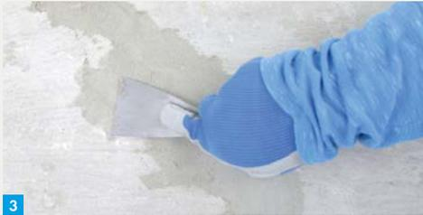
Überschüssige Füllmasse mit Spachtel entfernen. Bei Bedarf ausgebesserte Stelle mit Spachtel modellieren und an Umgebungsfäche anpassen.
