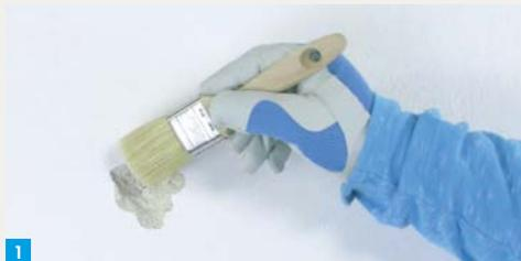
Staub und losen Schmutz, Farb- und Putzreste mit einem Pinsel entfernen. Sehr spröde Untergründe eventuell mit Wassersprüher oder Schwamm anfeuchten.
