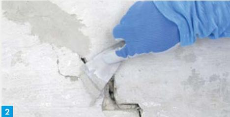
Mit Maurerkelle oder Spachtel angemischte Spachtelmasse großzügig in die Schadstelle einbringen. Bei Bedarf mehrere Schichten auftragen.
