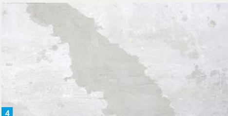
Ausgebesserte Schadstelle gemäß Anleitung trocknen lassen. Mit Werkzeug und Schleifpapier in Form bringen. Nach Bedarf weiterbearbeiten, z. B. überstreichen.
