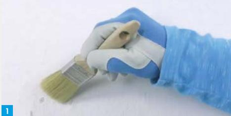
Staub und losen Schmutz, Farb- und Putzreste mit großem Spachtel oder Bürste entfernen. Sehr spröde Untergründe eventuell mit Wassersprüher oder Schwamm leicht anfeuchten.
