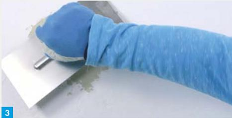
Mit Glättkelle aufgetragene Füllmasse in den Untergrund einarbeiten und glatt ziehen. Überschüssiges Material abtragen, bis eine ebene Fläche entsteht.
