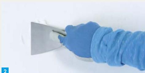
Spachtelmasse direkt aus der Tube in den Riss oder das Loch einfüllen oder Masse mit dem Spachtel großzügig auftragen und leicht andrücken.
