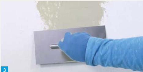
Mit Glättkelle aufgetragene Spachtelmasse in den Untergrund einarbeiten und glatt ziehen. Überschüssiges Material abtragen, bis eine ebene Fläche entsteht.
