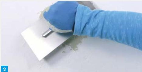
Angerührte oder gebrauchsfertige Spachtelmasse mit Mauerkelle oder Spachtel großzügig auf den unebenen Untergrund oder direkt auf eine Glättkelle auftragen.
